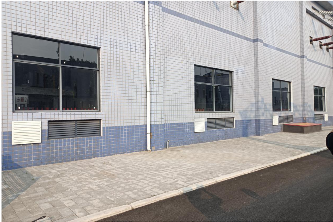
配电装置室装修改造完成
